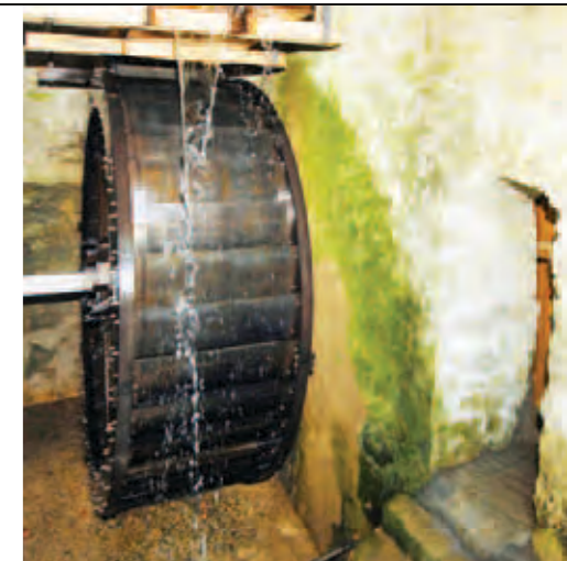
Seit April 2011 fließt Wasser über das neue Rad der Schöpfemühle, das als Stahl-Holz-Konstruktion ausgeführt worden ist. Auch die Getriebe- und Antriebstechnik sowie die Dreizylinderkolbenpumpe wurden instand gesetzt. Der Clou: Einen Generator zur Stromerzeugung baute man zusätzlich ein.
