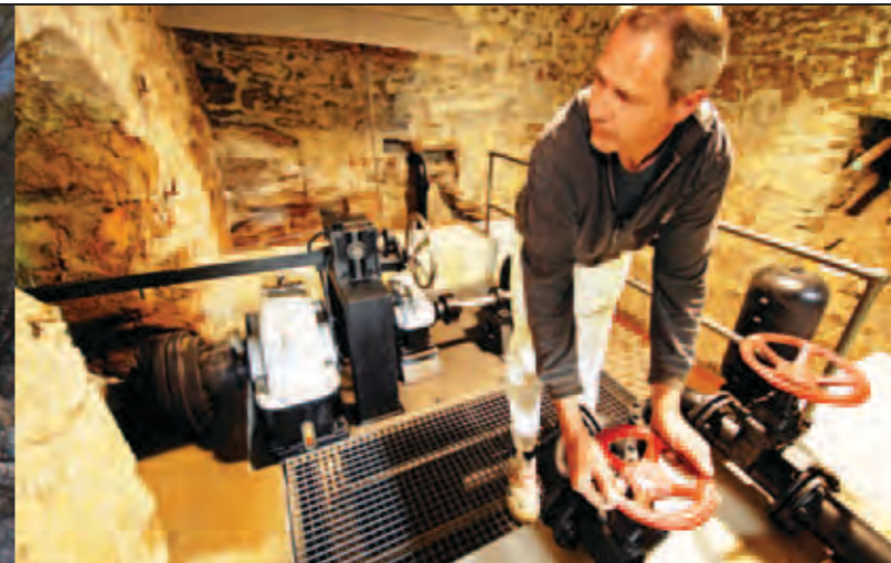
Seit April 2011 fließt Wasser über das neue Rad der Schöpfemühle, das als Stahl-Holz-Konstruktion ausgeführt worden ist. Auch die Getriebe- und Antriebstechnik sowie die Dreizylinderkolbenpumpe wurden instand gesetzt. Der Clou: Einen Generator zur Stromerzeugung baute man zusätzlich ein.
