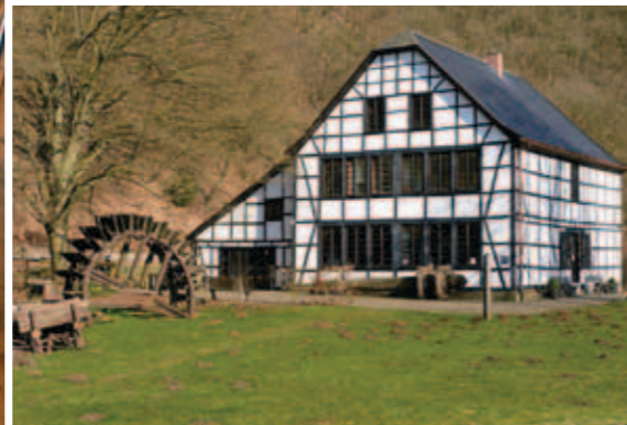
Nicht Strom, sondern Strömung trieb die vielen Schleifkotten an, die es früher an der Wupper gab. Im Balkhauser Kotten wurde die Bewegungsenergie des äußeren Wasserrades durch eine sechs Meter lange Holzwellen auf das innen liegende Kammmrad übertragen.
