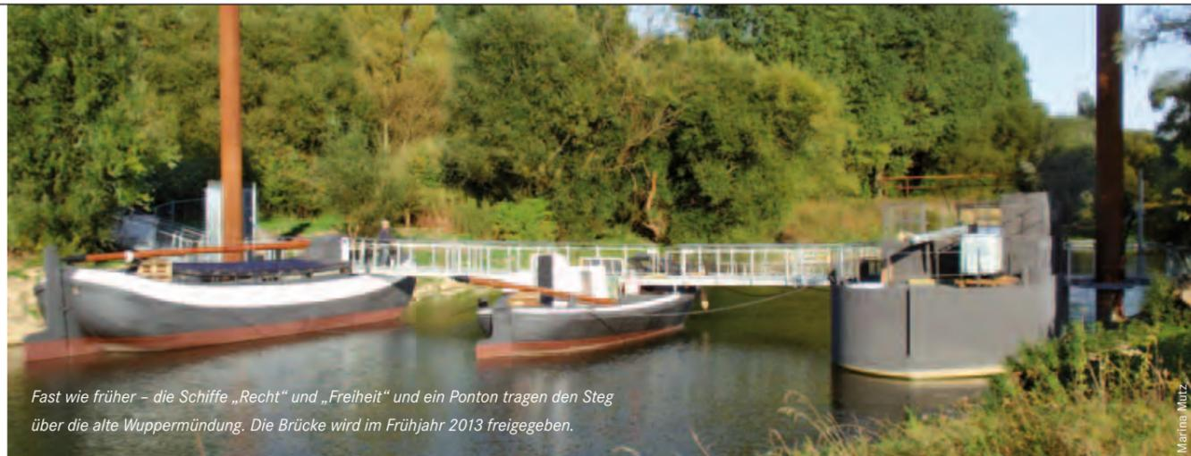
Fast wie früher – die Schiffe „Recht“ und „Freiheit“ und ein Ponton tragen den Steg über die alte Wuppermündung. Die Brücke wird im Frühjahr 2013 freigegeben.
