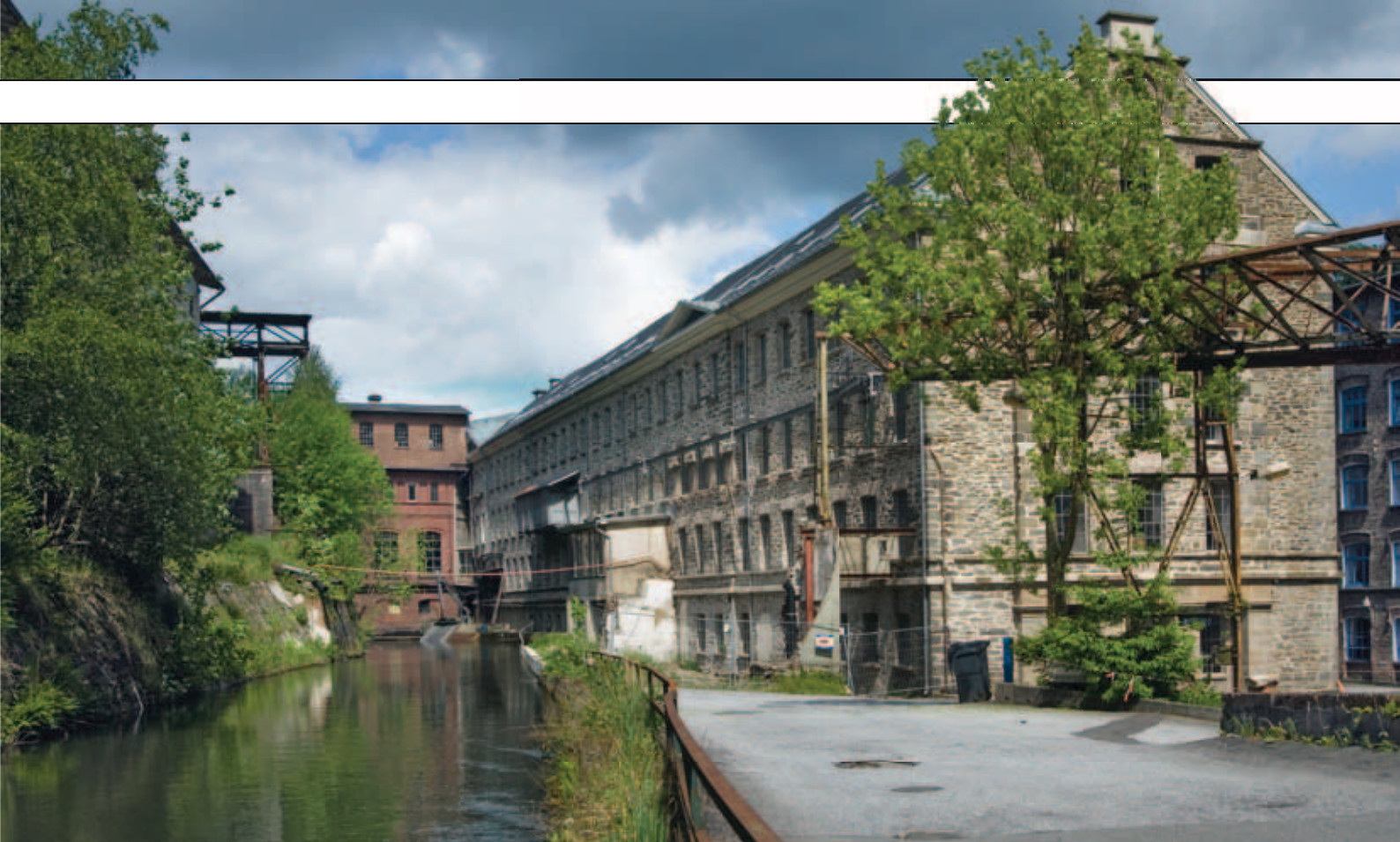
Der Wuppergraben verläuft mitten durch das Firmengelände. Wasserkraft war anfänglich die wichtigste Energiequelle der Weberei und ein wichtiger Grund für die Ansiedlung in dem Flusstal. Das Foto zeigt das Hauptgebäude des Unternehmens, in dem sich auch das Museum befindet. Die ganze Textilstadt Wülfig umfasst ein weit größeres Areal.
