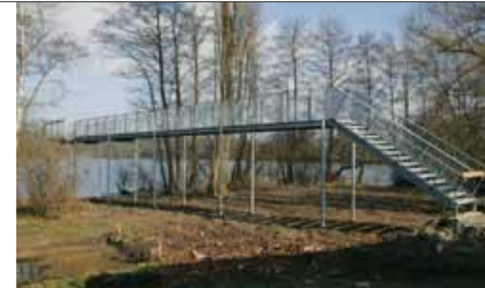
Über 30 Meter lang ist der neue Steg, der über den Hinsbecker Bruch führt und den Besuchern einen spannenden Ausblick bietet.
