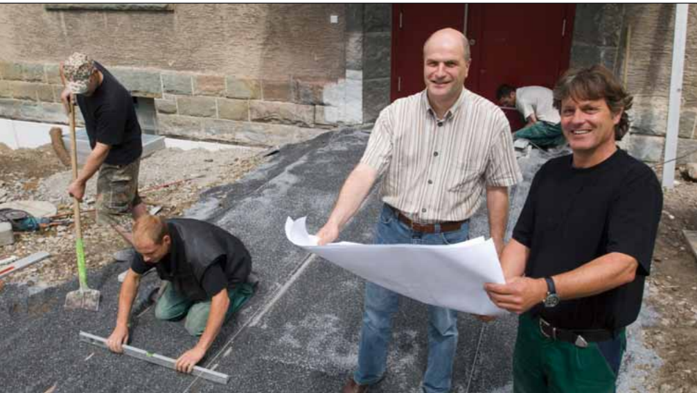
Andreas Knapp (2. von rechts) ist Geschäftsführer der INI und leitet die Umbaumaßnahmen in der Flakkaserne Lippstadt.
