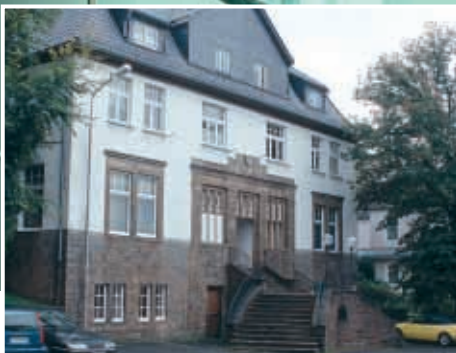
Das Kiersper Amtshaus mit Bruchsteinsockel, repräsentativer Freitreppe und unverkennbaren Jugendstil-Elementen.
