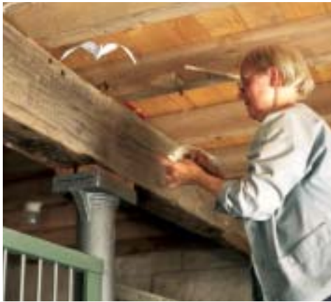
Architektin Inge Breidenbach zeigt im Tuppenhof, wo früher Schwalben mit den Pferden unter einem Dach lebten.
