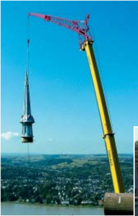
Ein Kran setzt die neue Kuppel auf das Dach von Schloss Drachenburg in Königswinter.
