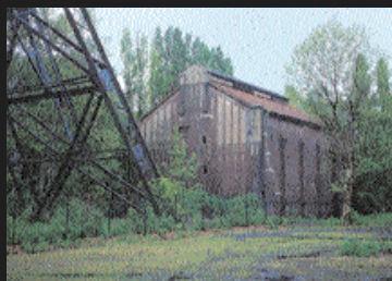
Maschinenhalle und Fördergerüst der Zeche Teutoburgia in Herne werden von Künstlern für Veranstaltungen genutzt.
