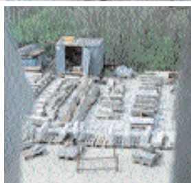
Zinnensteine der Terrassenmauern, zur Restaurierung zwischengelagert.
