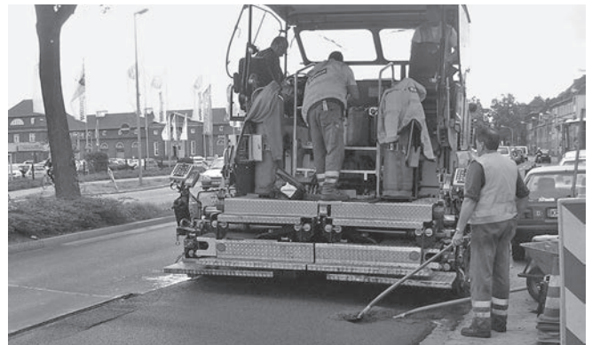
Die Straßendecken werden im Sommer an verschiedenen Stellen erneuert.
