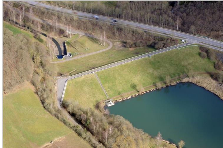
Abb. 16: Hochwasserrückhaltebecken Eicherscheid im Hauptlauf der Erft in der PE_ERF_1500 (Quelle: DIE GEWÄSSER-EXPERTEN! 2014).
