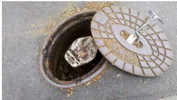
Abb. 24: Grundwassermessstelle in der Straßendecke (Quelle: LANUV NRW).
