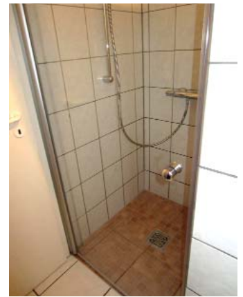
Nachher: Die Dusche ist bodengleich gefliest, die Glastür schafft maximale Durchgangsbreite.
