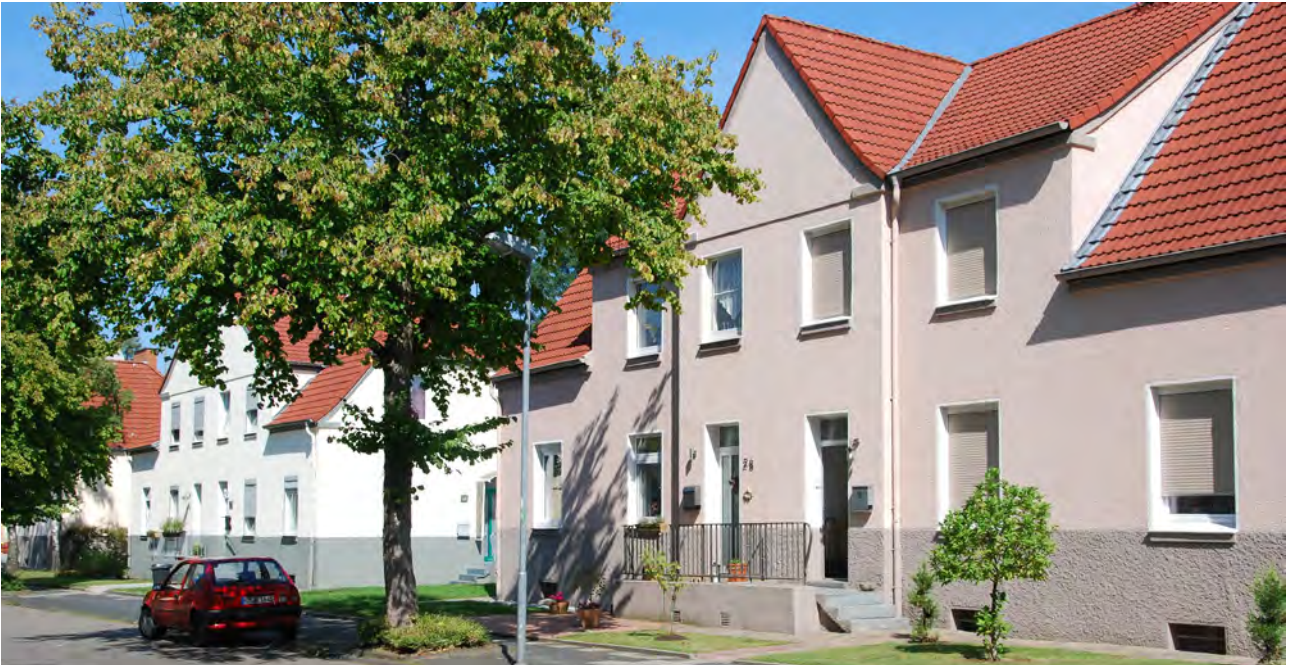
Nicht denkmalgeschützt, aber denkmalwert saniert: die Häuser in der Theobaldstraße in Essen-Katernberg. Fotos: Andreas Braun
