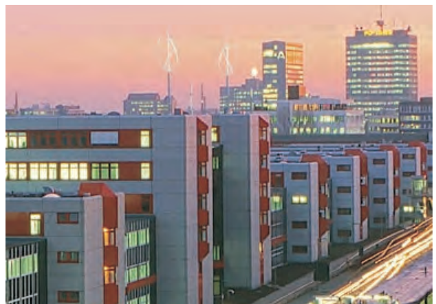
Essener Technologiezentrum mit Mikrowindanlage
