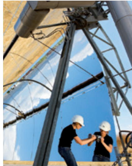
Parabolrinnenanlage in Spanien
