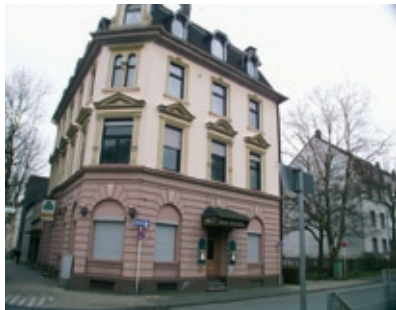
Eichenstraße/Rott vor dem Umbau
