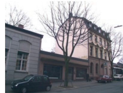
Eichenstraße vor dem Umbau
