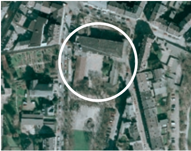
oben: Luftbild vom Platz der Republik rechts: der ehemalige Hochbunker
