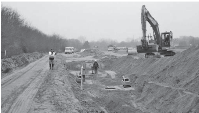
Der Ausbau des südlichen Hafenrings schreitet zügig voran.
