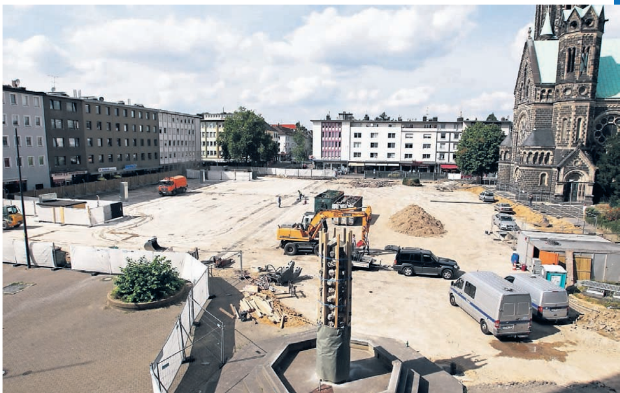
In Mönchengladbach tut sich was, die Stadt befindet sich im Aufbruch. Deutlich sichtbares Zeichen hierfür sind vor allem die zahlreichen Baustellen im gesamten Stadtgebiet, die als Indikator dafür gesehen werden können, dass sich die Vitusstadt für die Zukunft rüstet.
