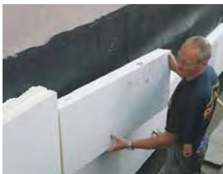
Abb. 84: Nachträgliche Abdichtung und Dämmung einer Kelleraußenwand
