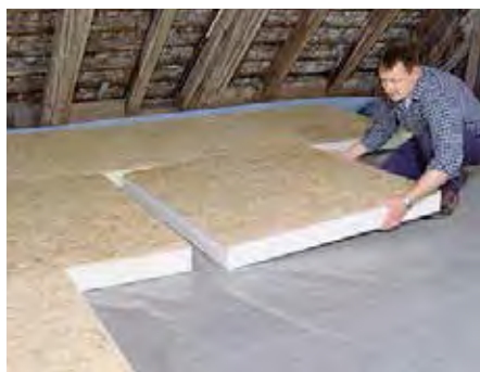
Abb. 86: Nachträgliche Aufdämmung einer Geschossdecke zu einem unbeheizten Dachraum
