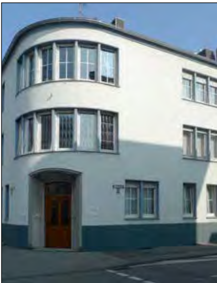
Abb. 92: Negatives Beispiel: Gebäude der Wiederaufbauzeit mit Sprossenteilung im Scheibenzwischenraum (Besser: Sprossenausbildung mit Wiener Sprossen, d. h. nicht glasteilenden Sprossen mit Steg im Scheibenzwischenraum)
