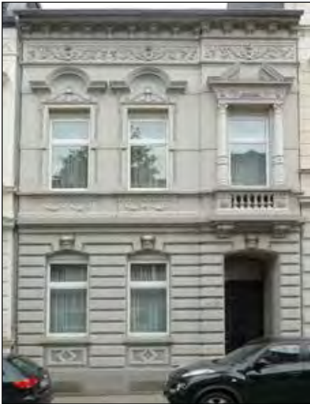
Abb. 90: Negatives Beispiel: Gründerzeitfassade mit nicht auf die Fassade abgestimmter Fensterteilung (Besser: Teilung des unteren Öffnungsflügels in zwei Öffnungsflügel)
