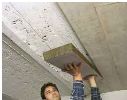
Abb. 85: Unterseitige Dämmung einer Preussischen Kappendecke
