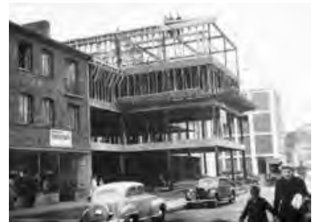
Abb. 34-35 (oben): Stahlskelettbau Hauptstr. 32-36 in zwei verschiedenen Baustufen (Quelle: Stadtarchiv MG, Sign. 10/31769 und 10/31935)
