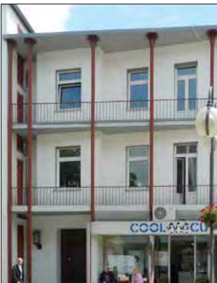
Abb. 94: Negatives Beispiel: Gebäude der Wiederaufbauzeit mit nicht auf die Fassade abgestimmter Fensterteilung (Besser: Teilung des unteren Öffnungsflügels in zwei Öffnungsflügel)
