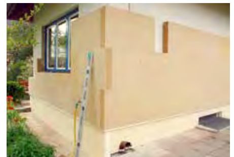
Abb. 76: Beispiel für nachträgliche Außendämmung mit WDVS, hier mit Mineralwolle-Dämmung an der aufgehenden Wand und mit extrudiertem Polystyrol-Hartschaum im Sockelbereich
