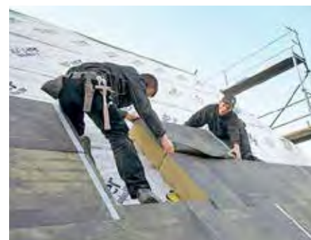
Abb. 88: Beispiel einer Aufsparrendämmung
