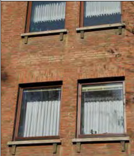
Positives Beispiel Fensterbänke: bauzeitliche Sohlbänke mit Konsolen, Marktstraße 19
