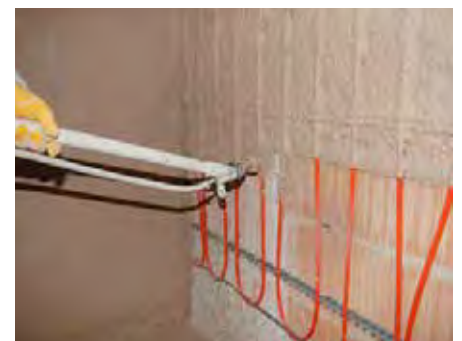
Abb. 83: Beispiel für eine Wandflächenheizung in einer Innenputzschale
