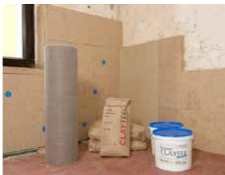
Abb. 80: Beispiel für nachträgliche Innendämmung mit Leichtlehm-Platten
