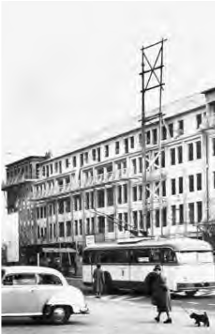
Abb. 38 (oben links): Limitenstr. 1-17 mit Fassadenstützen (Quelle: Stadtarchiv MG, Sign. 10/2/1533)
