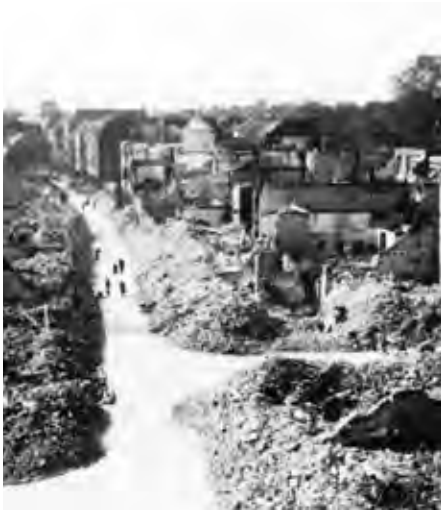
Abb. 8: Kriegszerstörungen an der Hauptstraße im September 1943 (Quelle: Stadtarchiv MG, Sign. 10/24517)
