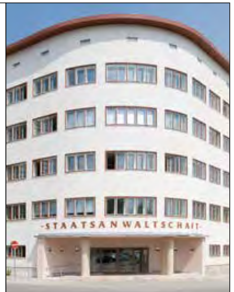
Abb. 93: Positives Beispiel: Fensterteilung in Abstimmung mit Fassadengliederung und mit der Bauzeit entsprechenden Fenstergliederungen (Fensterbänder)
