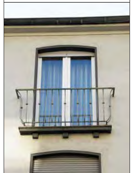
⊕ Positives Beispiel Fassade – Balkone und Erker: bauzeitlicher Zierbalkon, Hauptstraße 38
