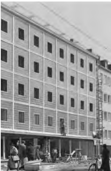
Abb. 40: Stahlbetonskelettbau – Baustellenaufnahme am Markt (Quelle: Stadtarchiv MG, Sign. 10/2/1534)
