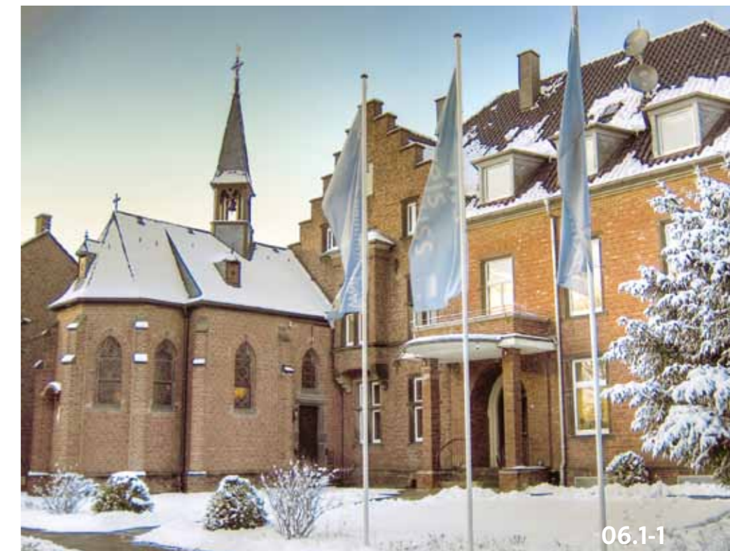
06.1-1 Das Technologiezentrum Glehn bietet moderne Kommunikationstechnologie in alten Gemäuern.
