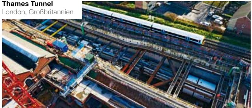
In London übernimmt HOCHTIEF Solutions seit 2011 in einem Joint Venture den Bau von zwei Tunnelröhren mit einer Gesamtlänge von etwa 5,5 Kilometern, die unter der Themse hindurchführen. Unser Los ist Teil eines riesigen Infrastrukturvorhabens: Ab 2018 wird eine
