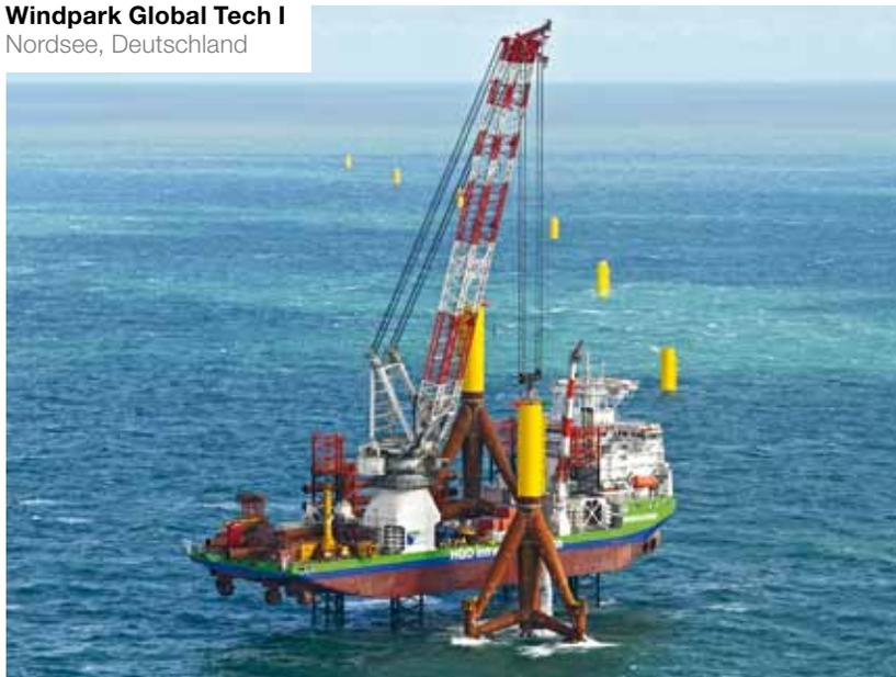
Im Sommer 2012 begann HOCHTIEF Solutions mit dem Bau des Offshore-Windparks Global Tech I. Insgesamt verankern die HOCHTIEF-Spezialisten 80 Fundamente mit einem Gewicht von jeweils zirka 900 Tonnen auf dem 40 Meter tiefen Meeresgrund. Die darauf montierten 5-Megawatt-Windenergieanlagen mit einer Höhe von jeweils rund 150 Metern werden künftig insgesamt 400 Megawatt Leistung erbringen. Der Windpark liegt etwa 180 Kilometer nordwestlich von Cuxhaven und damit außerhalb von Meeresschutzgebieten.
