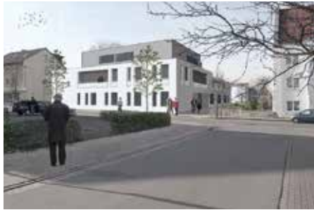
So soll das „Wohnen am Niedertor“ einmal aussehen. Bis dahin wird es noch bis Ende 2014 dauern. Doch der Grundstein ist bereits gelegt.
