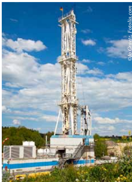
Auch bei Geothermiebohrungen muss die Qualität stimmen.
