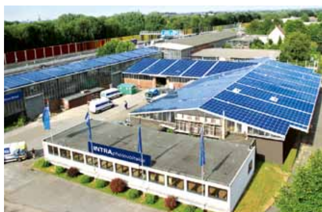
Firmengebäude in Bochum mit eigener Dachanlage
