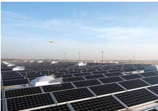
Flughafen Düsseldorf International, 135 kWp
