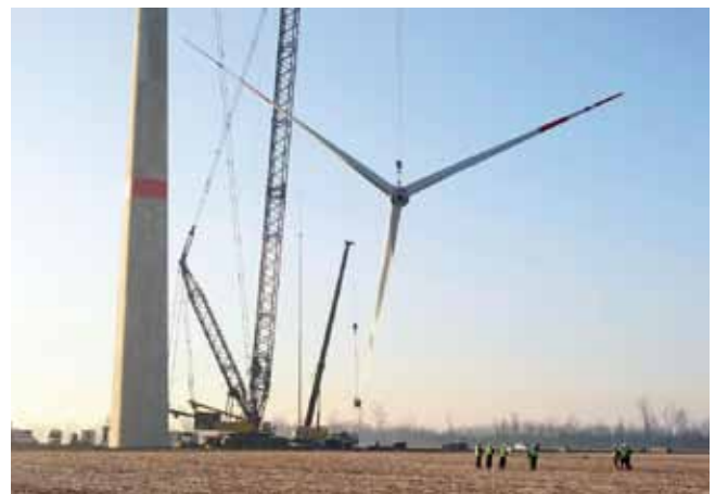
Bau eines Windparks in Grevenbroich, NRW
