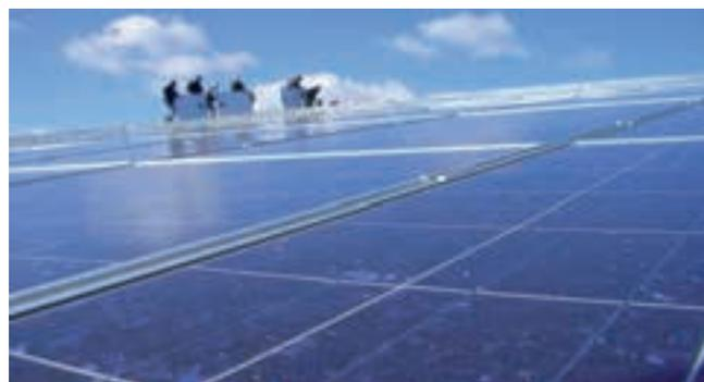
Großdachanlage auf einer Industriehalle 320 kW; Fläche ca. 2.500m<sup>2</sup>
