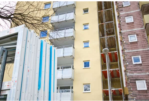
Neue Fenster sind nur ein Bestandteil der komplexen energetischen Sanierung von Wohnprojekten.
