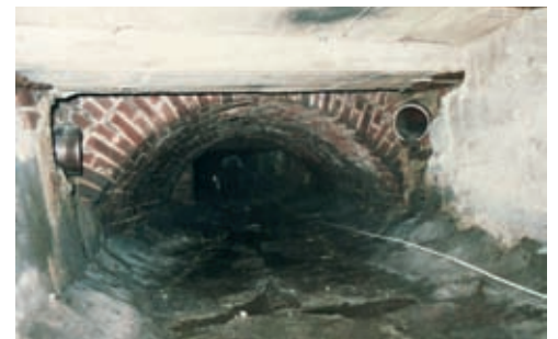
Blick in den Gladbachkanal.
