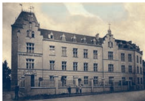
Das Krankenhaus Maria Hilf an der Viersener Straße.
