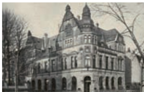
Das 1901 für die Gladbacher Gewerbank errichtete Gebäude Albertusstraße 44a um 1927.
