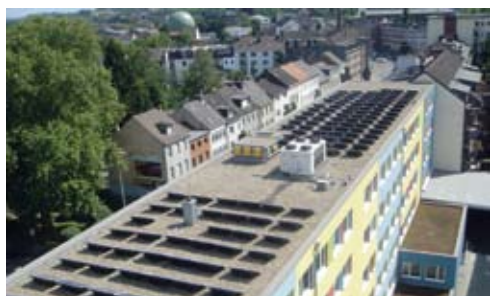
Anlage von IntraSolar auf dem Dach der ARGE Rheydt .
