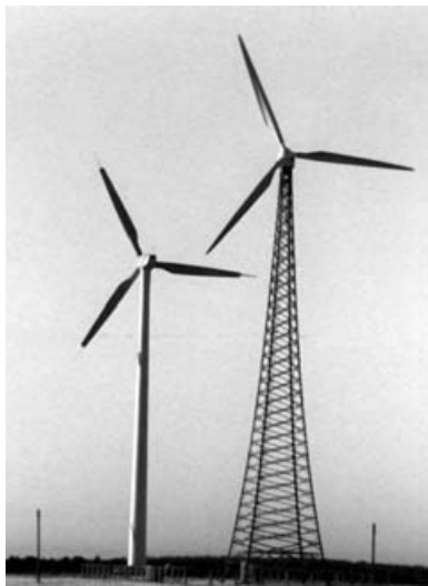
Am 21.05.2001 wurden gleichzeitig zwei Windkraftanlagen in zwei Ländern eingeweiht - in Geseke und - hier im Foto - im 1.300 km entfernten Drushnaja (Weißrussland).
