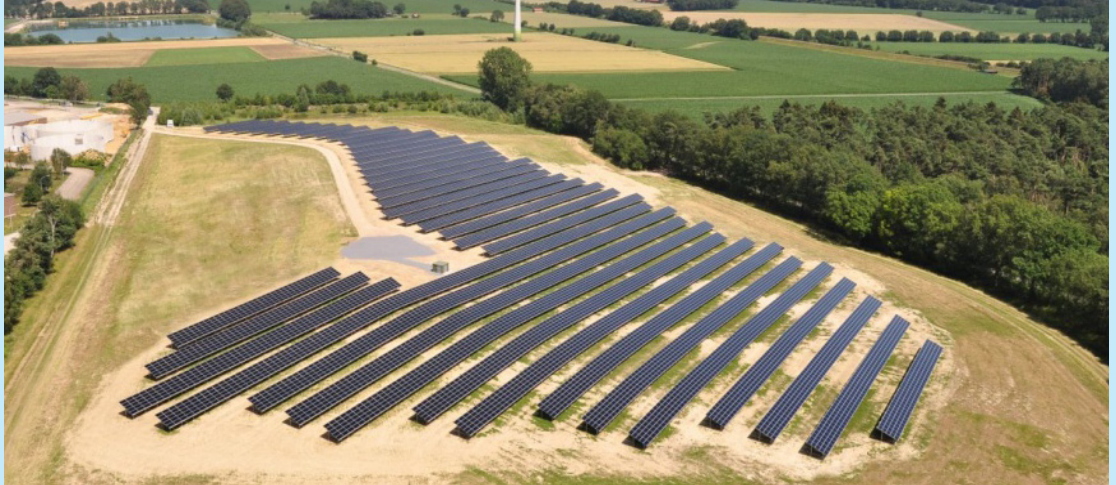
Abb. 14 Gesamtsicht der PV-Anlage auf der Bodendeponie Coesfeld-Flamschen Quelle: Wirtschaftsbetriebe Kreis Coesfeld GmbH
