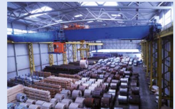
oben: DHL-Logistikstandort; unten: Schwergut-Verladung im Neusser Hafen
