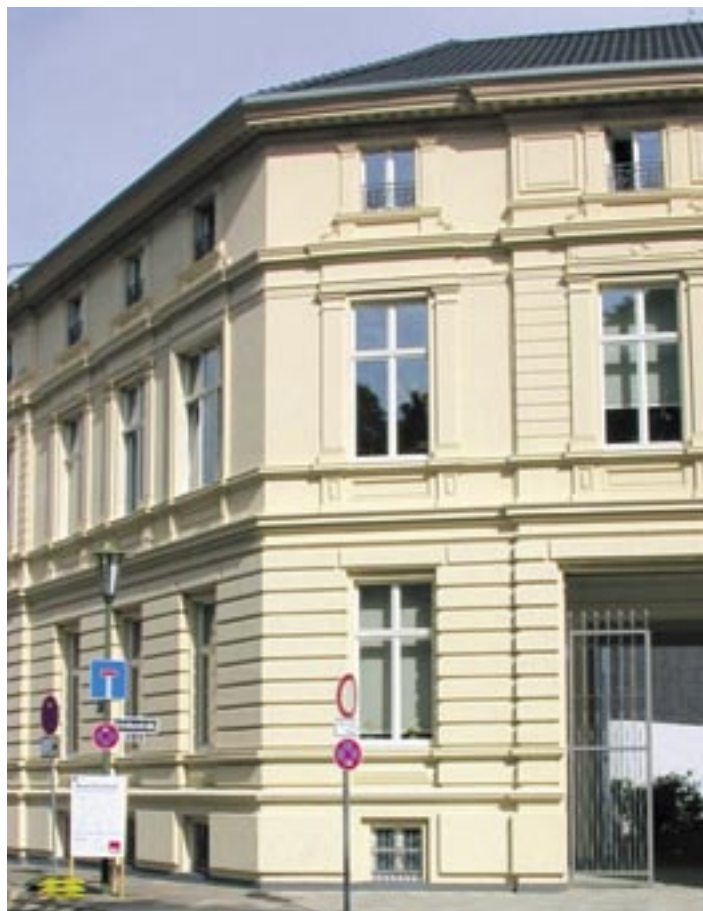
Abb. 31 | Scheibenstraße 63 im Stadtteil Pempelfort
