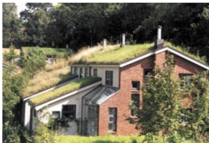
Abb. 28 | Schrägdachbegrünung in der Ökosiedlung Unterbach
