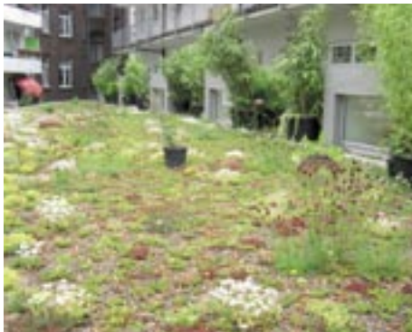
Abb. 25 | Extensive Dachbegrünung in der Gilbachstraße (250 m 2 )
