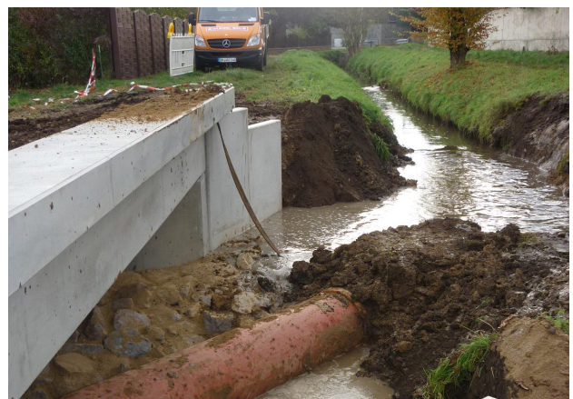
Bild 6.6 – Probetrieb Umschluss Oberwasser.
