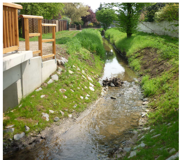
Bild 6.1 – Der Schlichbach bei Merken und Schophoven in seinem neuen Bachbett.
