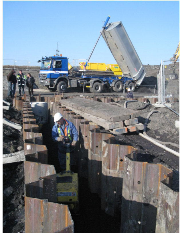
Bild 7.4 – Lageweises Verdichten des Filtergemisches in der teilreaktiven Wand
