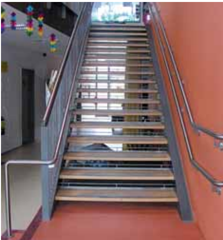
Treppe mit Handläufen und Sicherung der Setzstufen
