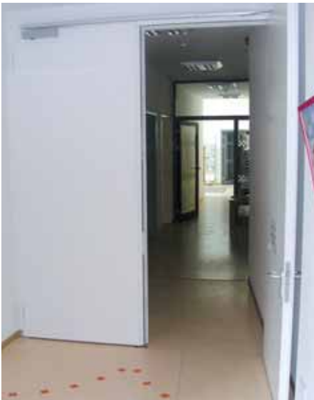
Brandschutztür mit Selbstschließfunktion
