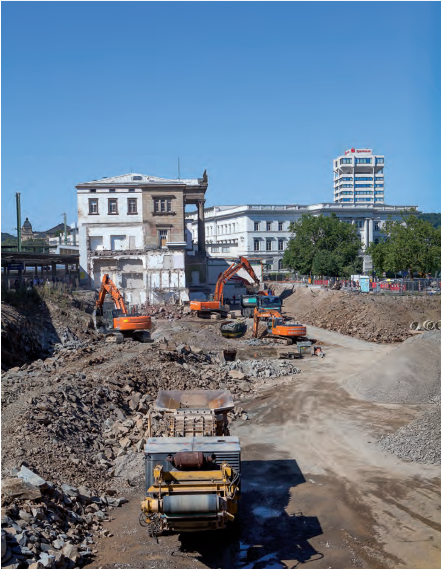
Kraterlandschaft an der Baustelle zum neuen Döppersberg
