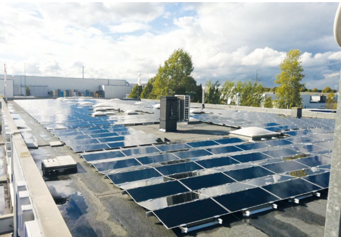
Durch ÖKOPROFIT angestoßene Installation einer Photovoltaikanlage auf dem Dach eines Betriebsgebäudes.
