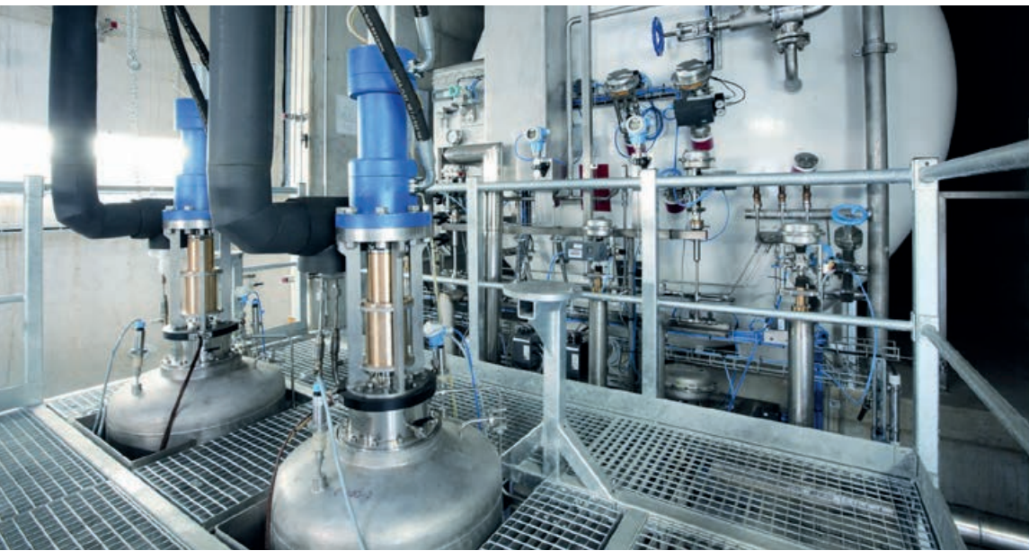
Abbildung 3.8: Kryopumpenanlage (Quelle: Linde AG)
