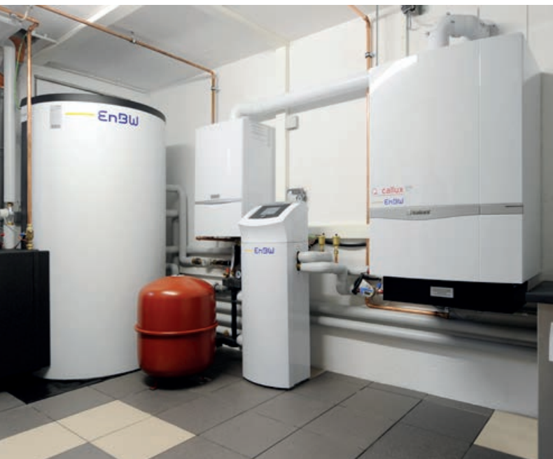
Abbildung 4.7: Vaillant-Feldtestanlage im bundesweiten Praxistest Callux. (Quelle: Vaillant GmbH)
