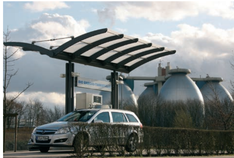
Abbildung 2.13: Tankstelle für Bioerdgas (Quelle: EuWaK)
