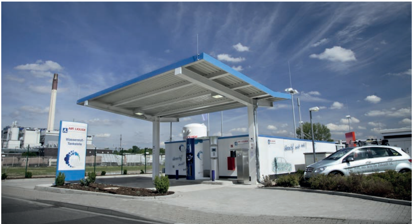
Abbildung 3.9: Gesamtansicht der H 2 -Tankstelle in Düsseldorf (Quelle: AIR LIQUIDE Deutschland GmbH)
