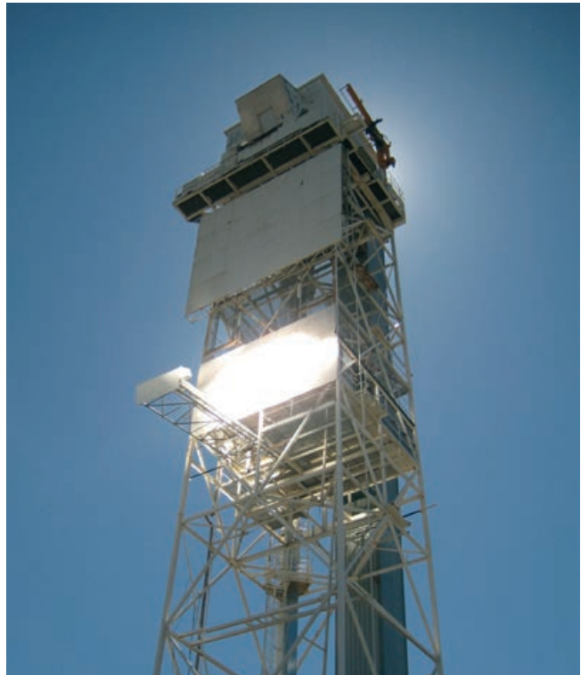
Abbildung 2.11: Pilotanlage zur solar-thermochemischen Wasserstoffherstellung auf einem Solarturm (Quelle: DLR)
