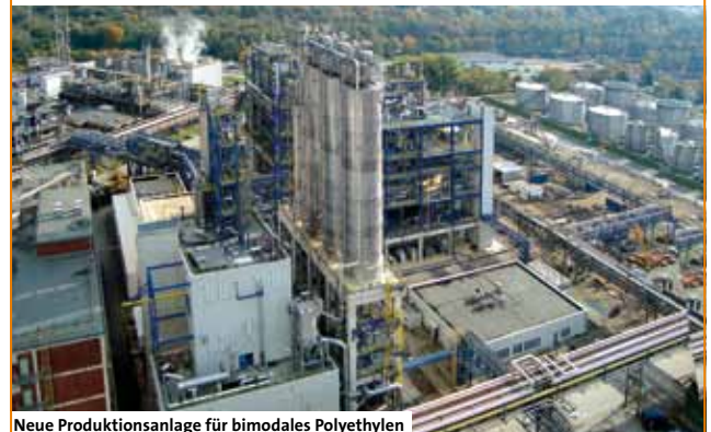
Neue Produktionsanlage für bimodales Polyethylen
