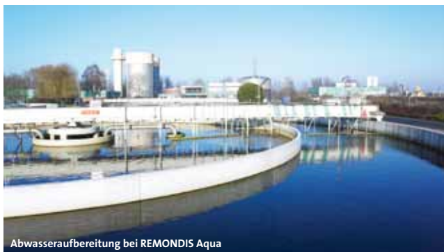
Abwasseraufbereitung bei REMONDIS Aqua
