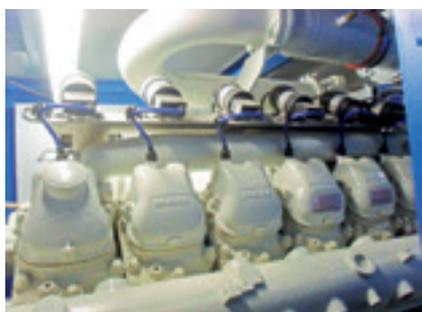
im Fokus. Zusätzlich zum Strom liefert das BHKW auch Wärme. Das erdgasbetriebene BHKW hat eine elektrische Leistung von 240 kW. Damit wird die Grundlast am Strombedarf des Unternehmens abgedeckt.
