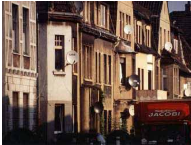
Straßenzug an der Gelsenkirchener Straße vor der Fassadengestaltung
