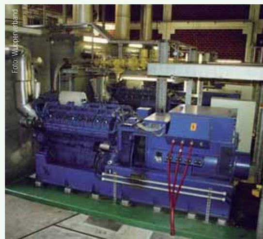
Im Klärwerk Buchenhofen in Wuppertal ist bereits seit 1998 ein BHKW im Einsatz, in dem aus Biogas Strom und Wärme erzeugt werden. Im Jahr können so etwa 9 Mio. kWh Strom regenerativ erzeugt werden, was dem Stromverbrauch von etwa 2.000 Vier-Personen-Haushalten entspricht.
