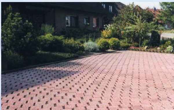
Ökologische Vorzüge bedeuten keinen verminderten Komfort bei der Nutzung von Flächen: durchlässige Befestigung eines PKW-Stellplatzes
