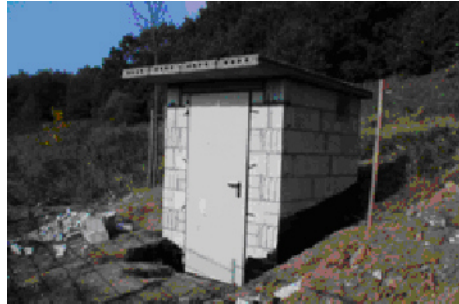
Einstieg zum Tiefen Stollen Erbenbank
