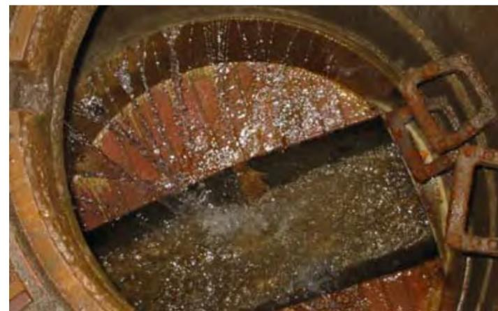
Abb.2: Grundwasserzufluss über Schachtfugen
