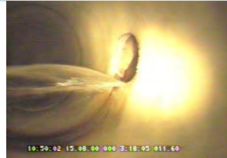
Abb. 3: Defekter Hausanschlusssutzen am öffentlichen MW-Kanal
