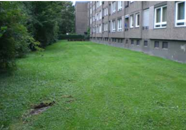
oben: Die Feuerwehzufahrt bei der Prüfung, hier als Rasenfläche erstellt.
