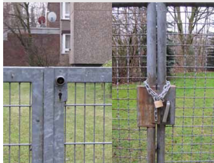
oben: Feuerwehzufahrten können auf verschiedene Weisen verschlossen sein. Zum Öffnen benötigt man einen Dreikantschlüssel, einen Bolzenschneider oder einen FBF-Schlüssel.
