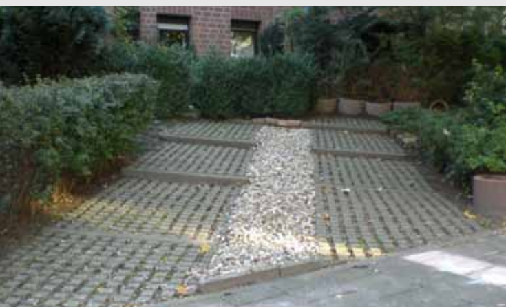
unten: Der Untergrund ist zwar ausreichend befestigt, jedoch ist der Neigungswinkel zu groß, so dass eine Drehleiter nicht in Stellung gebracht werden kann.
