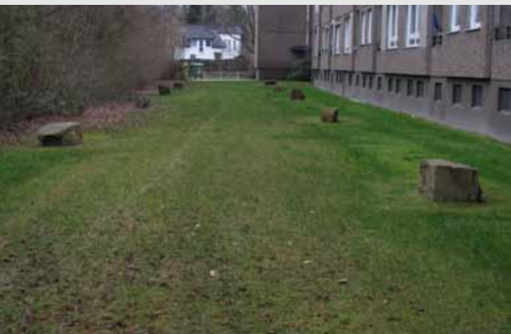
unten: Nach der Prüfung wurde nicht nur der Untergrund ertüchtigt, sondern auch die Hecke in der Zufahrt entfernt und die Fahrspur mit dicken Steinen kenntlich gemacht.
