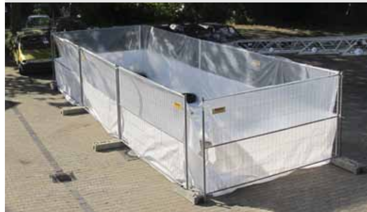
unten: Becken aus Bauzaunelementen mit Folienauskleidung
