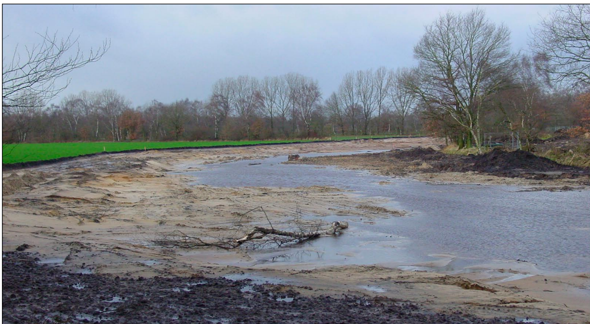
In den Umsetzungsfahrplänen werden Renaturierungsmaßnahmen und naturnahe Gewässerentwicklungen planerisch vorbereitet.
