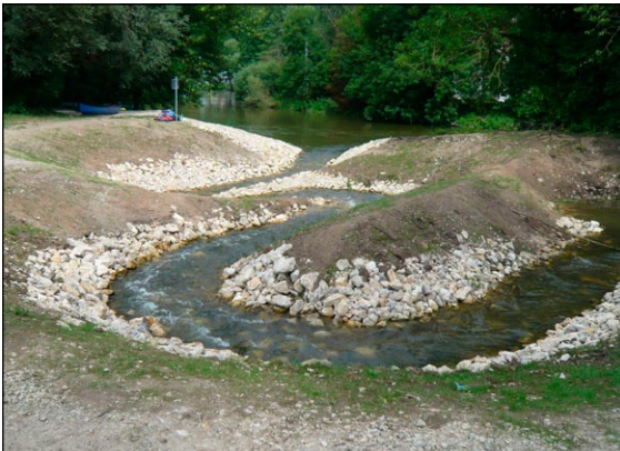
Fischaufstieg und -abstieg wird durch Umgehungsgerinne möglich. (Foto: S. Hänel)
